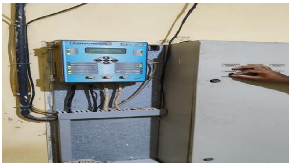
FIGURA 2 - Painel de controle do aviário demonstrando o desligamento dos exaustores para iniciar o “esquenta”.
